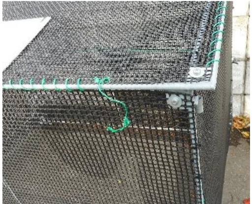
ゴミボックス破損の状況
